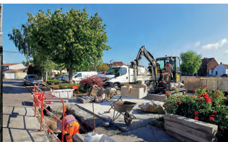
Réfection d'un trottoir rue Lanthier et de portions de trottoir place Pasteur et rue Carnot. Place Pasteur, ces travaux ont nécessité le remplacement préalable d'une canalisation endommagée.
