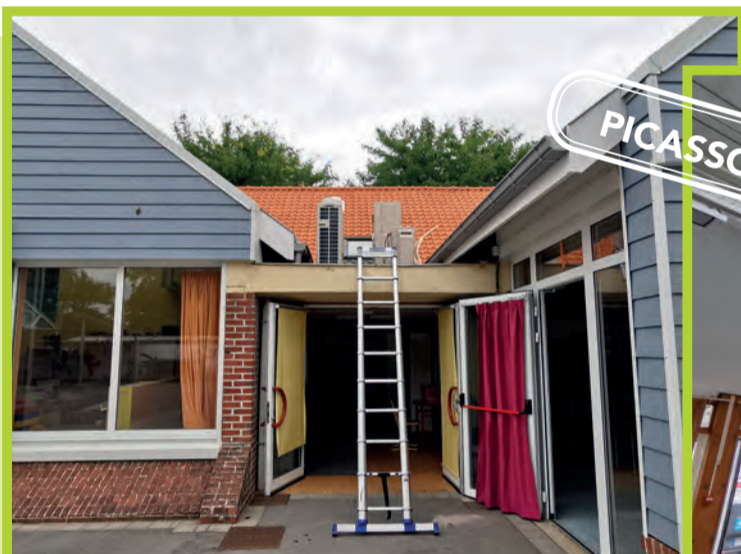
Installation de la pompe à chaleur.
