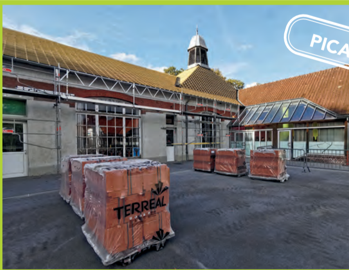
Réfection de la toiture.
