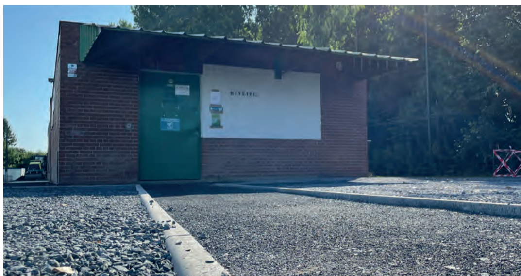
Aux abords des vestiaires du stade Georges-Cliquet, le schiste rouge a été remplacé par du ternaire et des allées en enrobé, pour limiter la boue et les ornières lors des fortes pluies.
