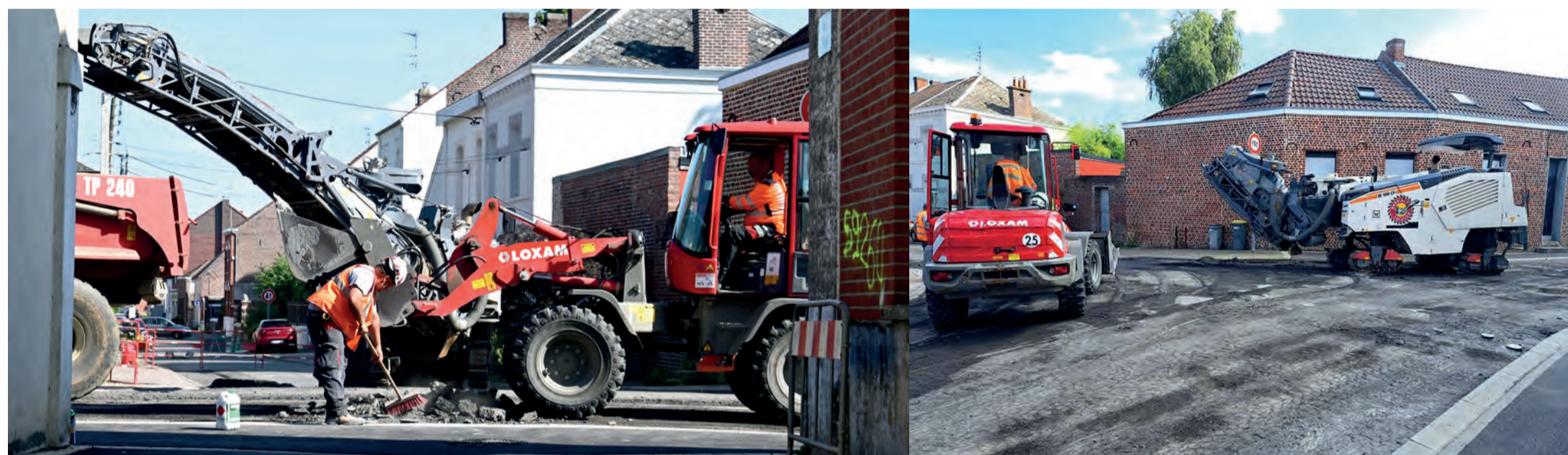
Dans le cadre des travaux du Cœur de Ville, les trottoirs et voiries ont été refaits au cours de l'été à l'angle des rues Mirabeau, Pasteur et Dolet.
