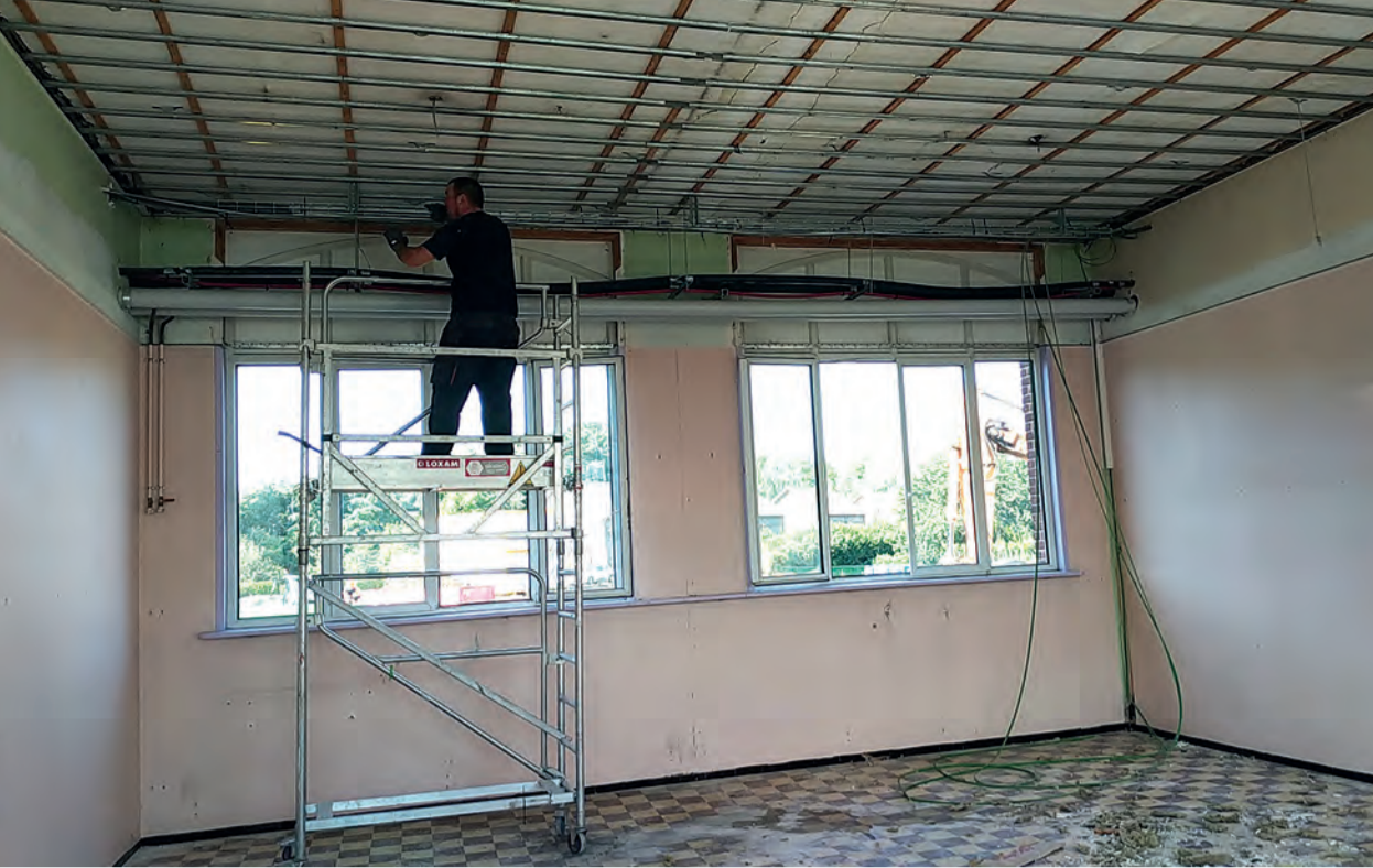
▲ Dépose des câbles de l'école avant réhabilitation.
