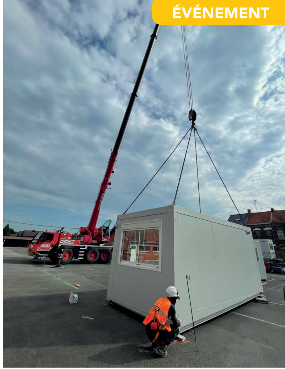
▲ Arrivée et placement des modulaires.
