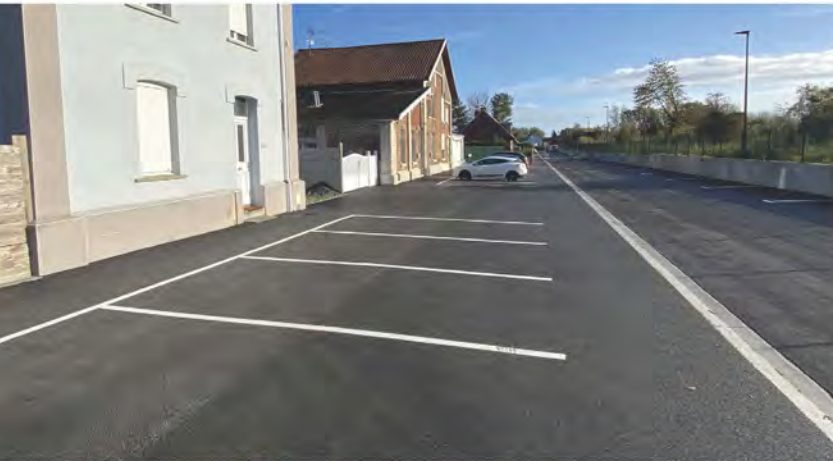
GRANDS TRAVAUX AMÉNAGEMENT DE L'IMPASSE DES E.M.O TERMINÉ !
