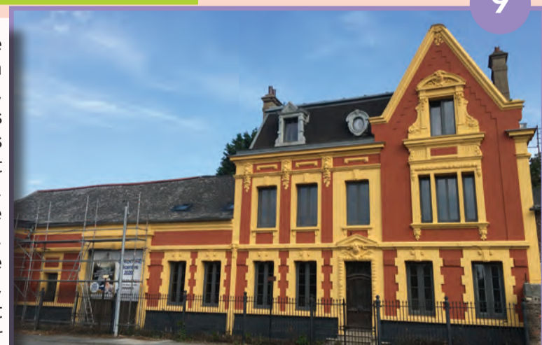
Suite des travaux à la Brasserie Mochez
