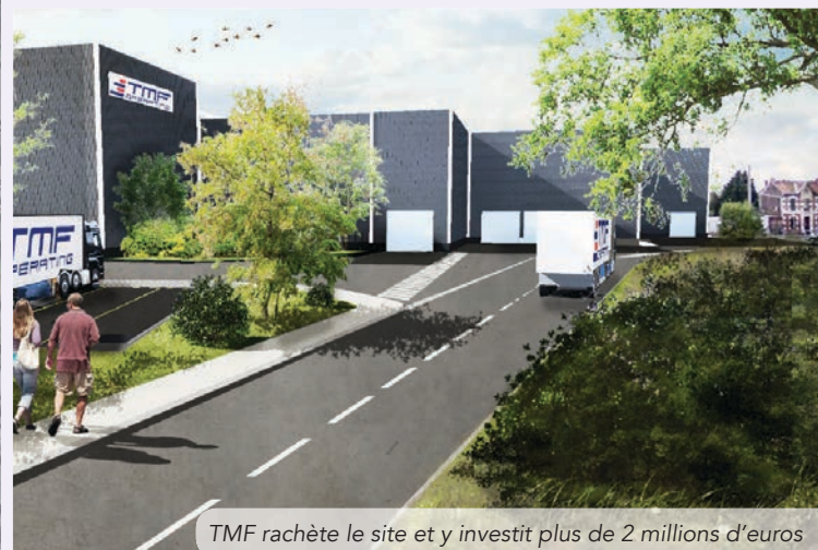
Démolition de la maison du garde barrière rue de l'Industrie
