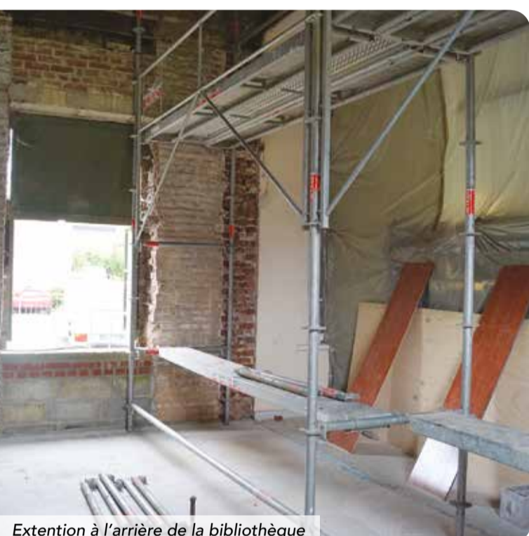
Extention à l'arrière de la bibliothèque
