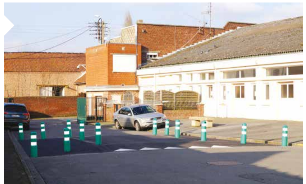
Pose de plots et rétrécissement de la chaussée pour plus de sécurité à la salle des fêtes et complexe Léo Lagrange
