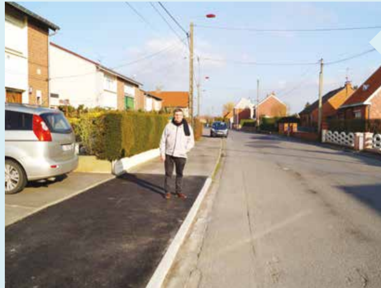
Abaissment des bordures Chemin des Baudeliers pour faciliter l'accès aux garages
