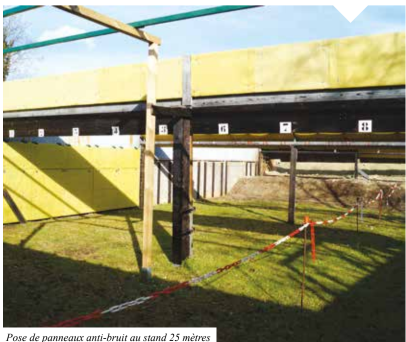
Pose de panneaux anti-bruit au stand 25 mètres
