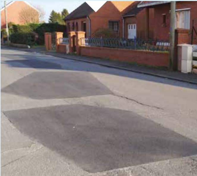
Après les travaux de réfection de la chaussée du Chemin des Baudeliers
