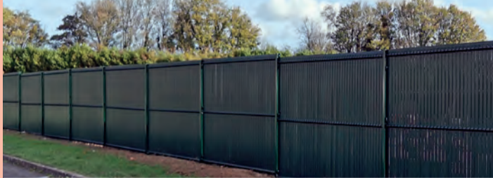
Remplacement de la partie de clôture incendiée en septembre et automatisation des deux portails.
