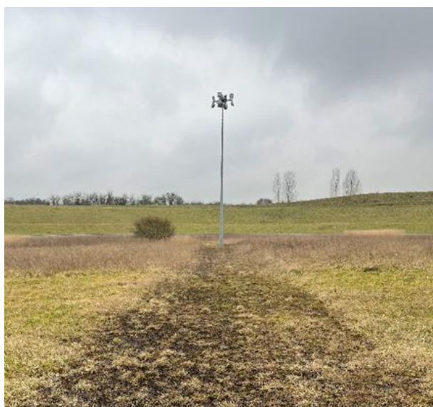
6) Eclairage au niveau de la zone de retournement sud (identique au nord)
